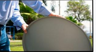
O apontamento é feito movimentando lateralmente a antena, buscando a direção correta para o satélite, e movendo-a para cima e para baixo, a fim de encontrar a elevação adequada. É importante observar sempre o medidor de qualidade do receptor.
